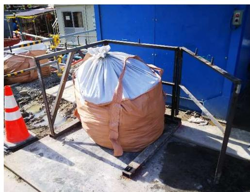
④ 満タン（2バッチ）後は口を閉め、架台を開きトンバックを回収。引っ掛かることなく吊り上げが容易になった。
