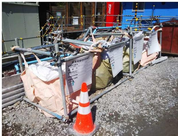
単管パイプで架台を作成したが、トンバック交換時にクランプが引っかかり、手間が掛かった。（写真は産廃置き場の単管パイプ架台）
