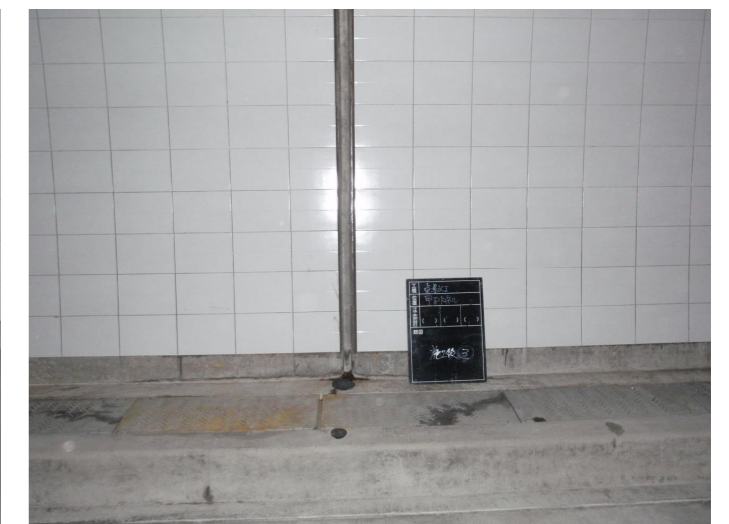
【点導水N】施工後
