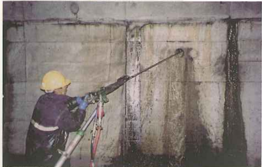
ベースホールから地山に向かって、ボーリング孔を掘削している様子。放射状に3本、ボーリングした
