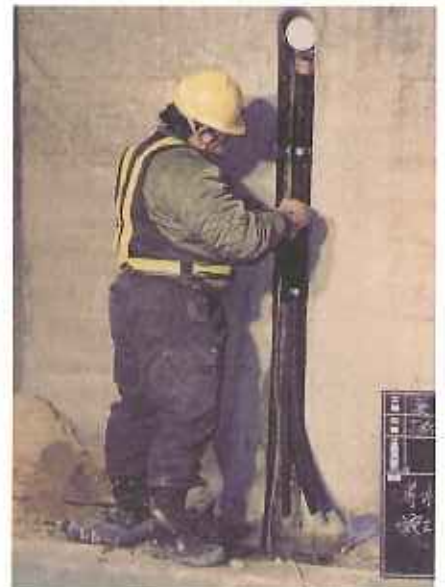
水が抜けた後、ベースホールの下にパイプを取り付けているところ
