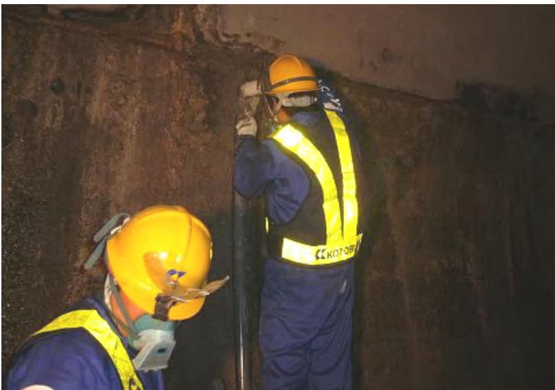
導水パイプ設置
