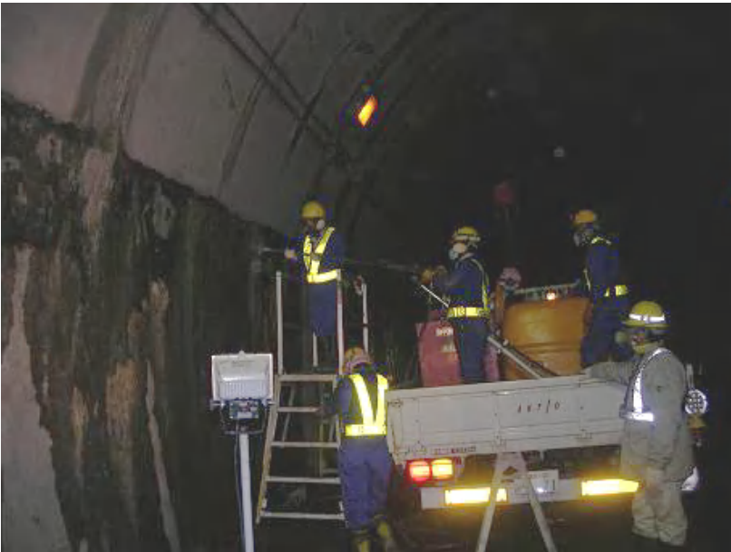
口元削孔作業状況
