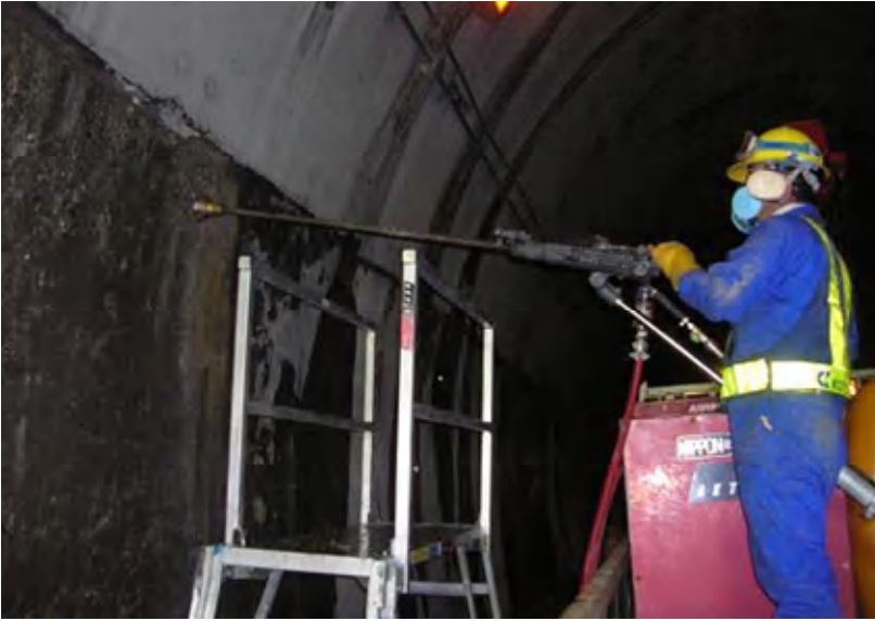
口元削孔 ( \phi 120mm)
