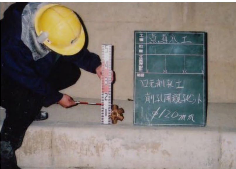
口元削孔用 親子ビット ( \phi 120mm)
