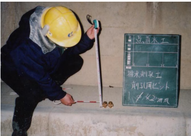
水抜き削孔用 ビット (φ42mm)
