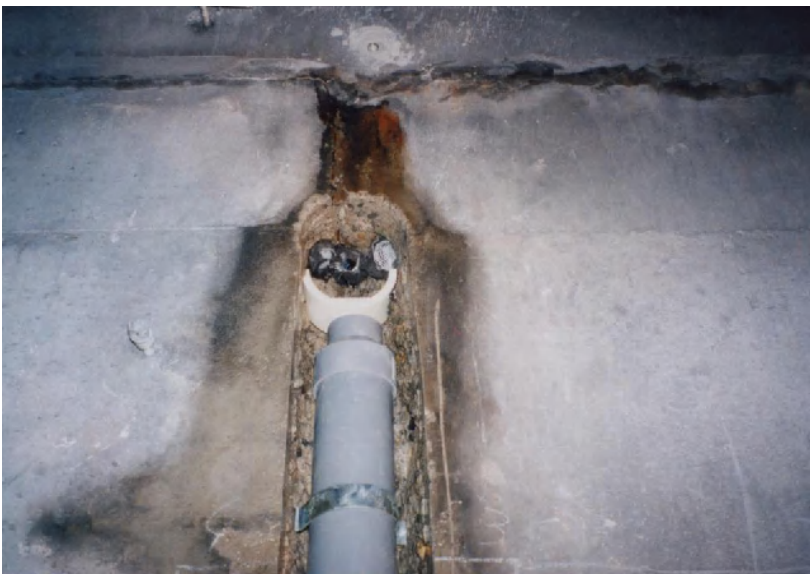
受け皿導設置状況 (受け皿は特製品)
