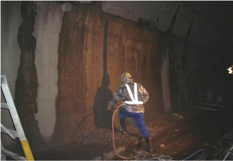
導水工 導水部 ハツリ
