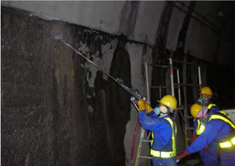
水抜き削孔 (φ42mm)
