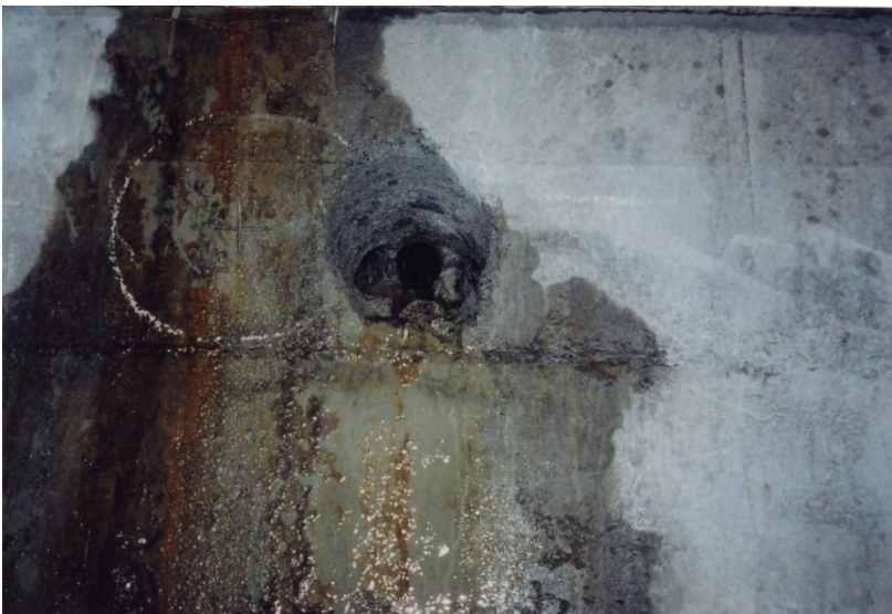
水抜き削孔完了
