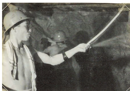
高熱隧道内をホースで水をかけて冷却している様子
